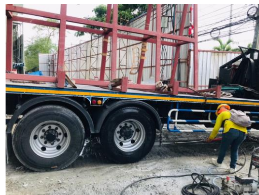
รูปที่ 17 พื้นที่สำหรับล้างล้อรถบรรทุกเข้า-ออกโครงการ
