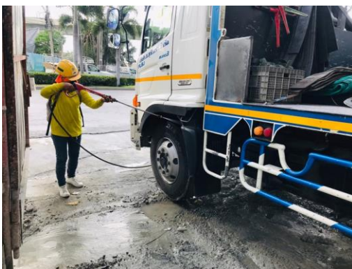
รูปที่ 17 พื้นที่สำหรับล้างล้อรถบรรทุกเข้า-ออกโครงการ
