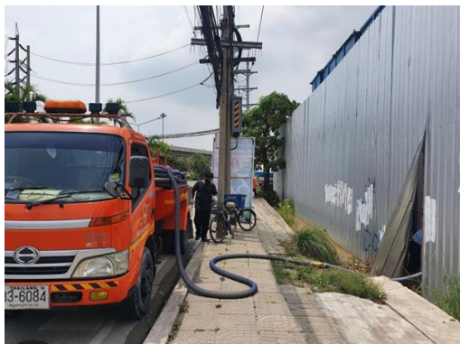
รูปที่ 25 การสูบน้ำจากตะกอนส่วนเกิน
