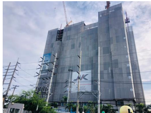
รูปที่ 10 ติดตั้ง Mesh sheet
